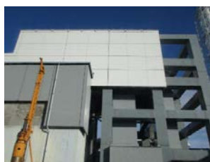
4号機 燃料取り出し用カバー
