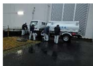
非常用発電機への給油
